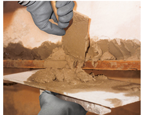
Naprawa gzymsów balkonowych: Nanoszenie Planitop 400
