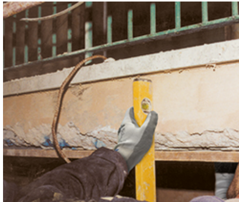
Naprawa gzymsów balkonowych: montaż deskowania
