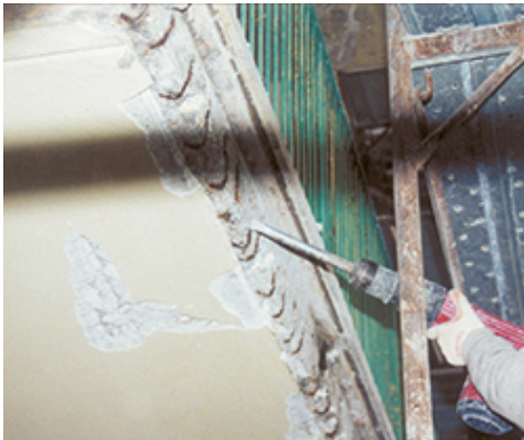
Naprawa gzymsów balkonowych: przygotowanie podłoża
