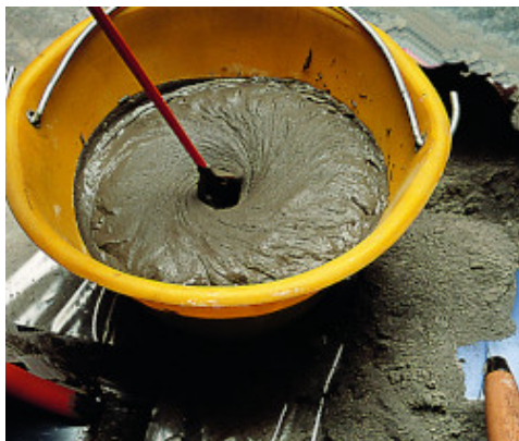
Mieszanie zaprawy Nivorapid za pomocą mieszadła wolnoobrotowego
