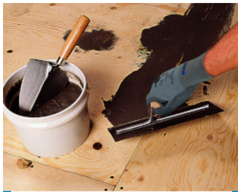
Szpachlowanie podłoża ze sklejki przy użyciu zaprawy Nivorapid zmieszanej z Latex Plus
