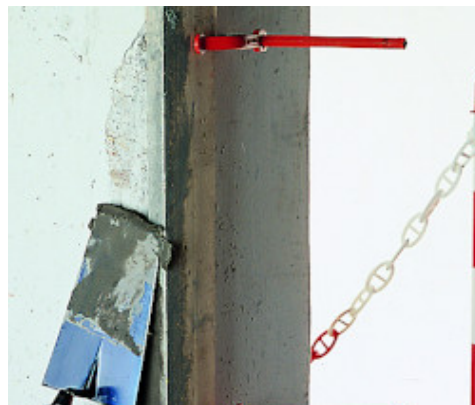
Naprawa pionowego narożnika zaprawą Nivorapid
