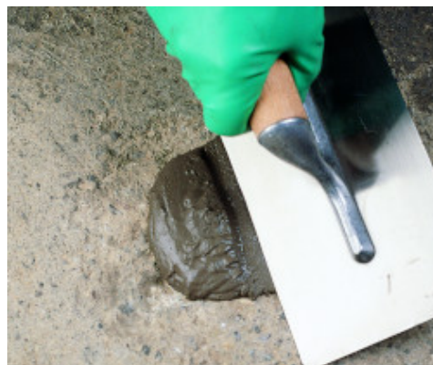
Naprawa poziomej krawędzi przy użyciu Nivorapid
